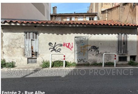
Entrée 2 - Rue Albe
