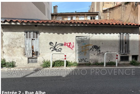
Entrée 2 - Rue Albe
